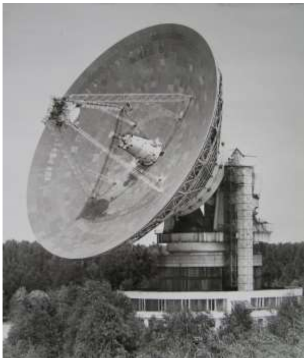
Фото 18. Антенная система ТНА - 1500, диаметр зеркала 69 метров.
