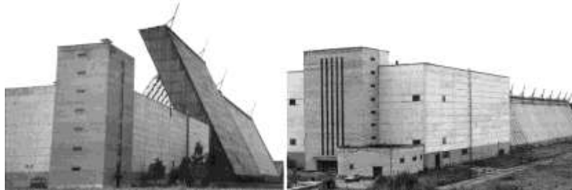
Рис. 3. РЛС "Дунай-ЗУ" – приёмная (слева) и передающая позиции – сооружения, измеряемые сотнями метров [6]
